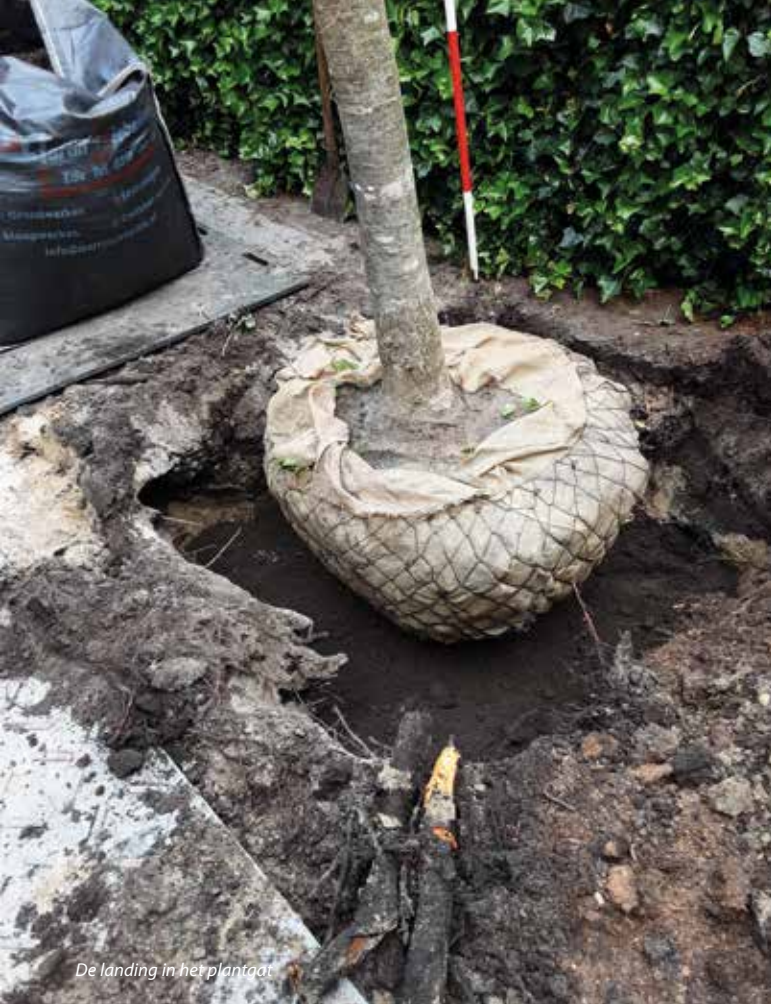
Ondergrondse kluitverankering
