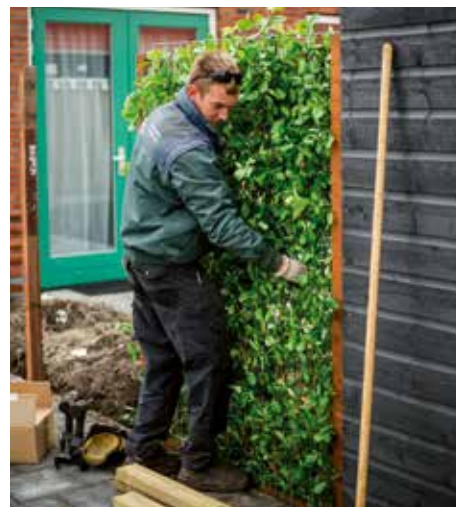
Na het graven van een gleuf wordt de Kant & Klaar Haag in de grond gezet.
