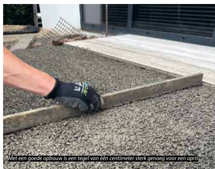
Keramische tegels, verwerkt volgens de Romfix-methode op drainagemortel
