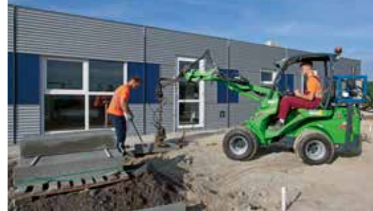
Trottoirbanden plaatsen. Rechts Sidney Simonis, op de machine medewerker Martijn
