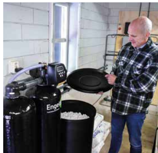
De opdrachtgever bij de ontijzerings-/ontkalkingsinstallatie en het vat met regeneratiezout
