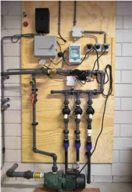
Verdeling en drukregeling van het gezuiverde water over drie aparte beregeningsgroepen
