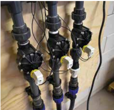
Alle drie elektrisch bediende beregeningsgroepen heeft Van Gelder voorzien van sensoren.
