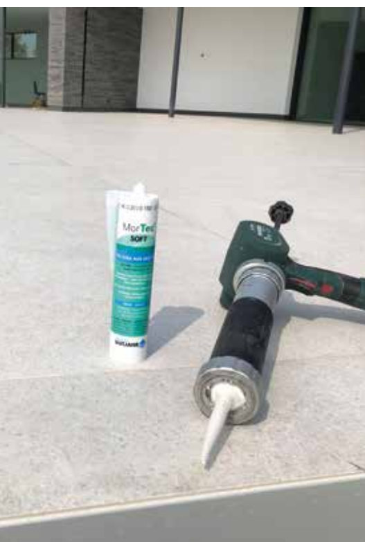
Schade die is ontstaan door vocht onder de tegels
