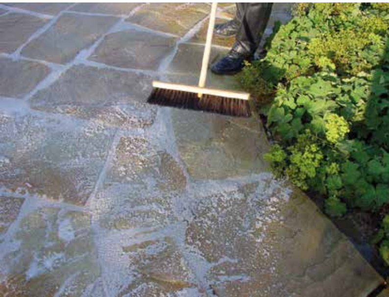
Links: flagstones met drainagemortel Varistone Z, naturel. Rechts: flagstones-opbouw met drainagemortel Varistone Z, steengrijs
