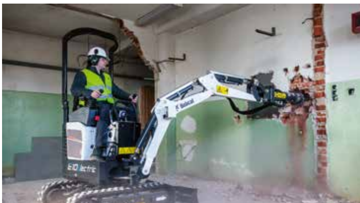
Ook voor inpandig sloopwerkzaamheden door bouwgerelateerde bedrijven is de E10E erg geschikt
