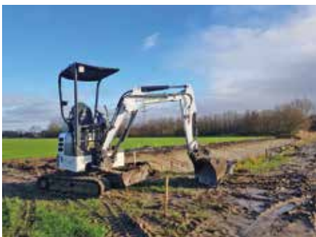
Plaatsing van amfibieëschermen voor de aanleg van een zonnepark
