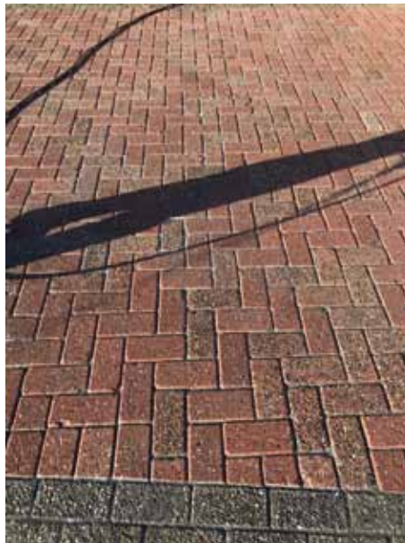
'Verschillende stappen tijdens het aanbrengen van de polymere voeg Stoneflex op een testlocatie in Kerkdriel'
