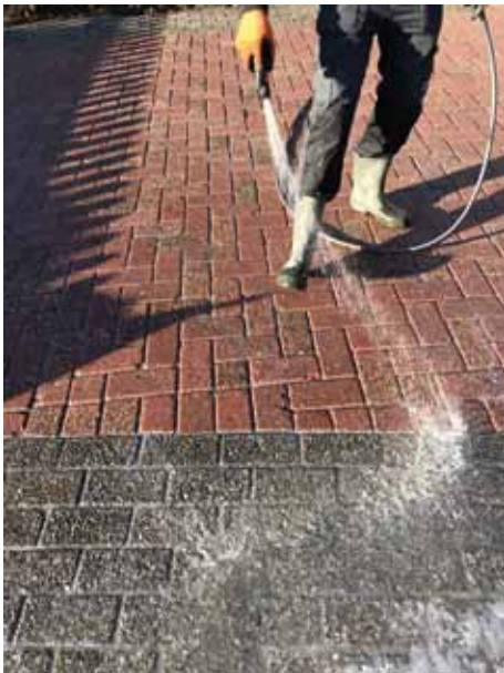
'Verschillende stappen tijdens het aanbrengen van de polymere voeg Stoneflex op een testlocatie in Kerkdriel'
