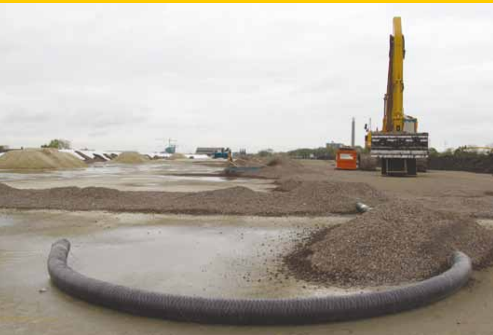
Lava en drainageslangen op het dak van de A2.
