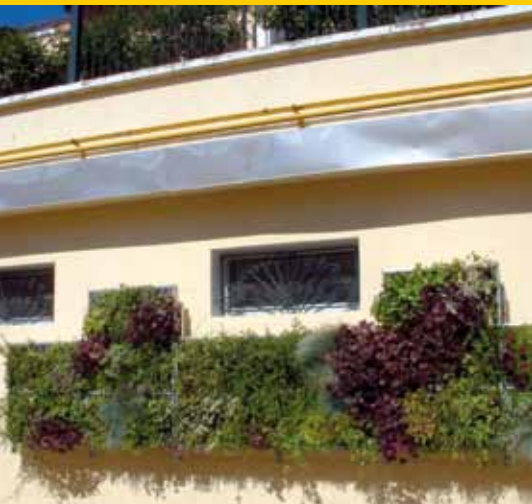
binnentoepassing in Zwitserland, Zurich – met een waterreservaat onder in het frame
