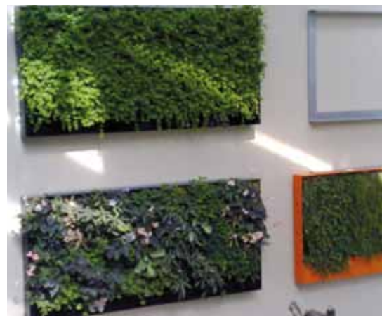
binnentoeepassing in Zwitserland, Zurich – met een waterreservoir onder in het frame
