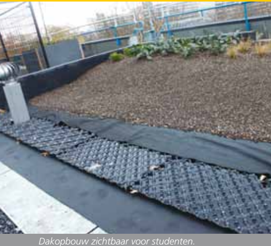
Dakopbouw zichtbaar voor studenten.
