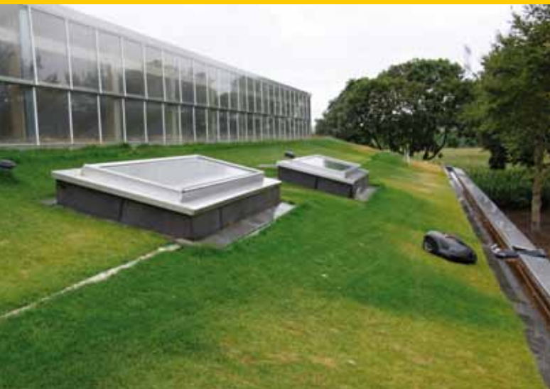
Grasdak op de nieuwbouw van Van Helvoirt Groenprojecten.
