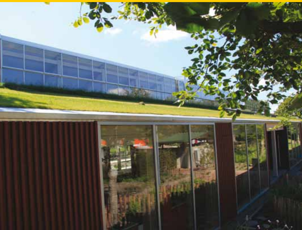
Het filterdak op de nieuwbouw.
