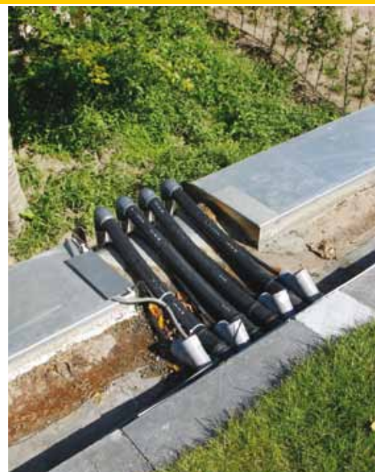
De in- en uitlaat van het afvalwater naar het grasdak.
