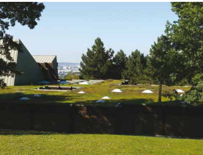
ZinCo-daktuin in Esslingen (DE) uit 1977; nu, 35 jaar, later nog steeds een plaatje. De referenties, die tellen!
