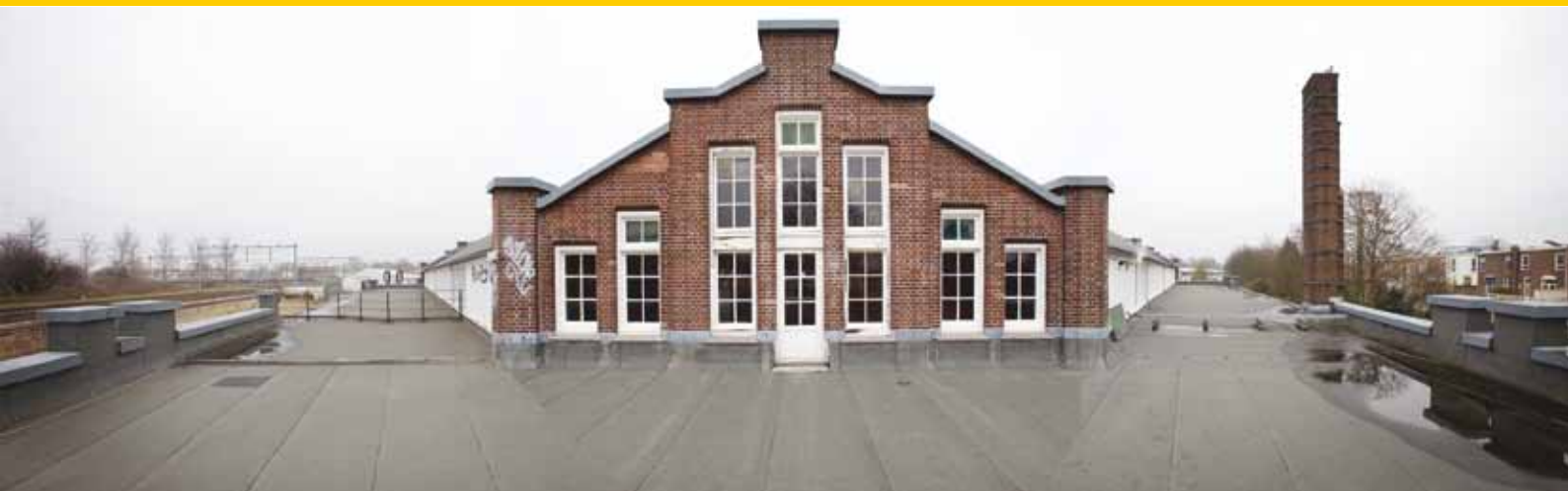
Het dak in Haarlem waar de tuin gerealiseerd moet worden.
