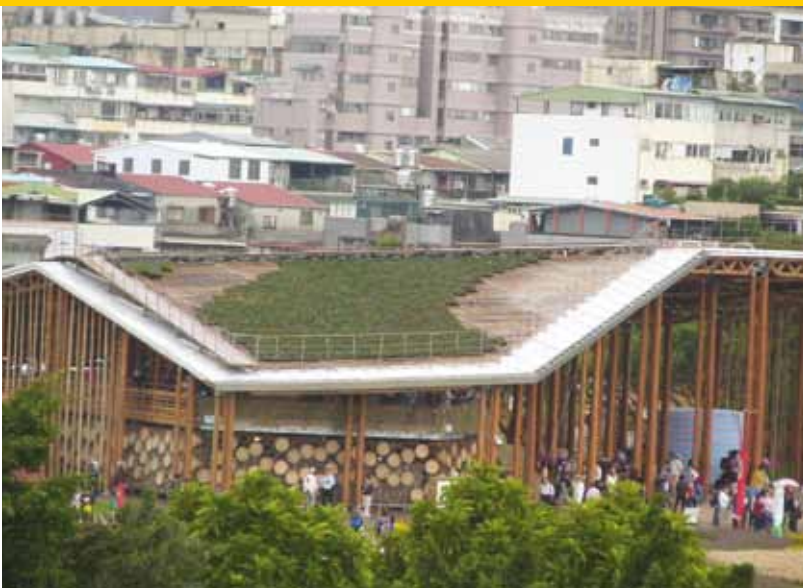
Foto 1: Gebouw met op het dak een frame van bamboe met daartussen planten.
