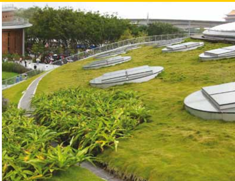
Foto 2: Intensieve dakboeiing met zonnepanelen.
